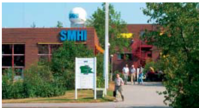
Abb. 3: Der SMHI Gebäudekomplex wurde 1974-75 in einem früheren Marktgarten in der Nähe des Stadtzentrums von Norrköping gebaut.
